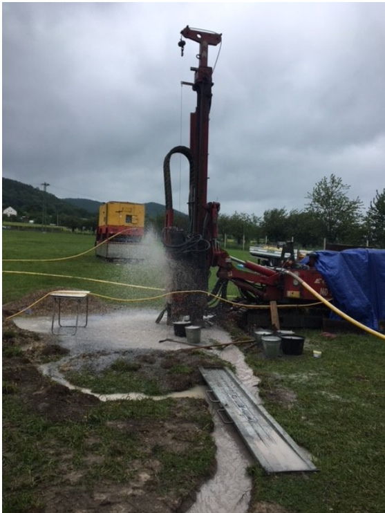
Obrázek č. 12 Hloubení vrtu HVC-1 Velemín a výnos cenomanských slepenců
